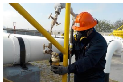
Imagen 1. Toma de muestra para la determinación de la corrosividad del fluido.
